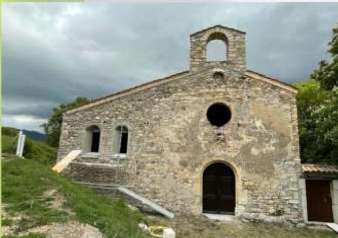
Travaux de restauration de l'Eglise St Clément du Vieux village.. Reprise des encadrements fenêtres. Réalisation et pose de 7 vitraux. Réalisation et pose de grilles de protection . Traitement de la fissure présente sur le mur intérieur nord, le déblaiement des pierres et gravats présents au sol à l'intérieur ainsi que du nivellement du sol
